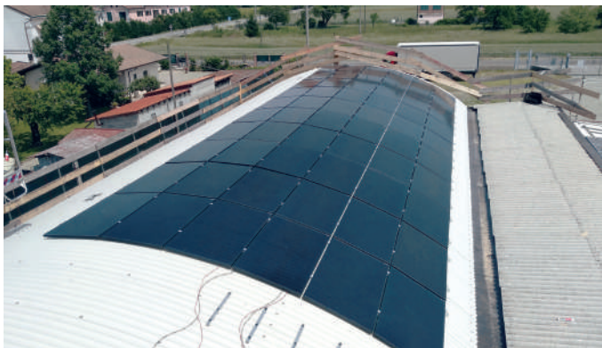
Lavori di rifacimento del tetto e l'installazione dei nuovi pannelli fotovoltaici
